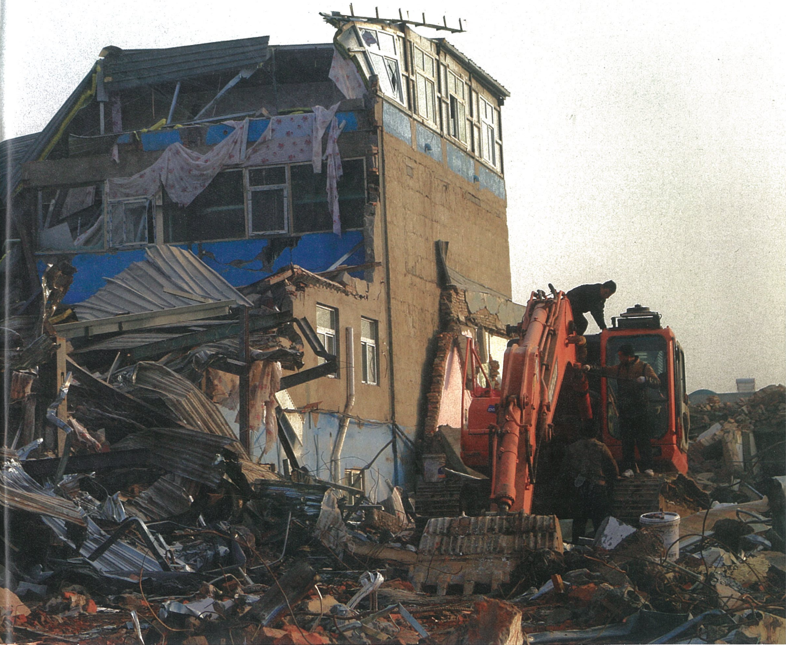
▲ 拆迁中的房屋与修整中的挖掘机
